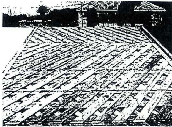
タルキの上にタイベックを張り、その上にアミパネルを張る
